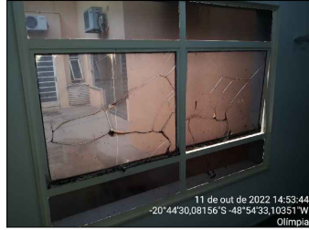
Foto 41 - CORREDOR DE ACESSO
