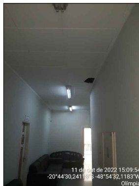
Foto 55 - CORREDOR DE ACESSO
