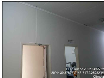
Foto 43 - CORREDOR DE ACESSO
