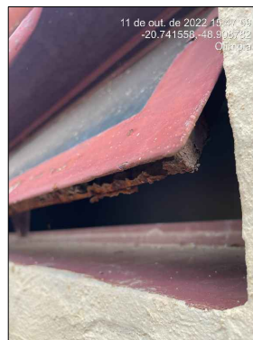
Foto 86 - Janela Banheiro Fundo
