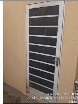
Foto 50 - ÁREA DESCOBERTA (P-31)
