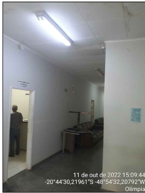
Foto 53 - CORREDOR DE ACESSO
