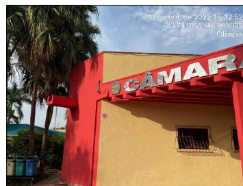
Foto 92 - Hall de Entrada
