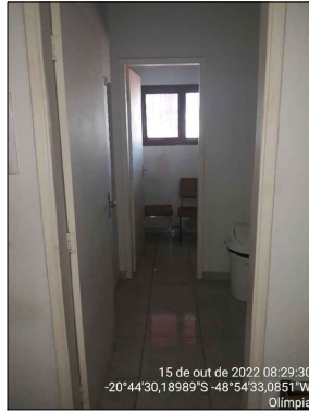
Foto 83 - HALL DE LIMPEZA
