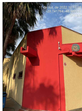
Foto 90 - Hall de Entrada
