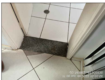
Foto 13 - Banheiro Sala do Presidente da Câmara
