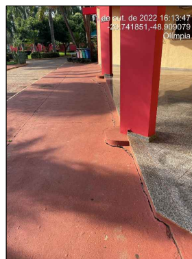
Foto 88 - Hall de Entrada
