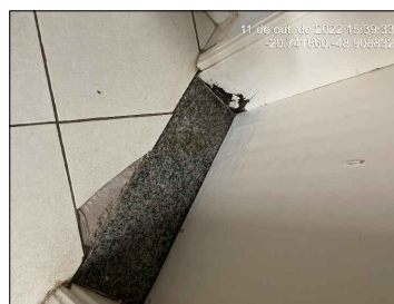
Foto 14 - Banheiro Sala do Presidente da Câmara
